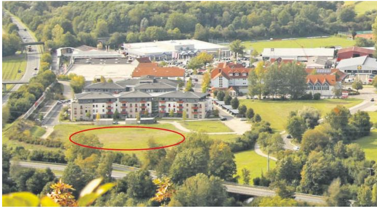
Unterhalb der Seniorenresidenz am Rande des Hohenstädter PEZ (roter Kreis) soll das neue Awo-Pflegeheim entstehen. Fotos: J. Ruppert
