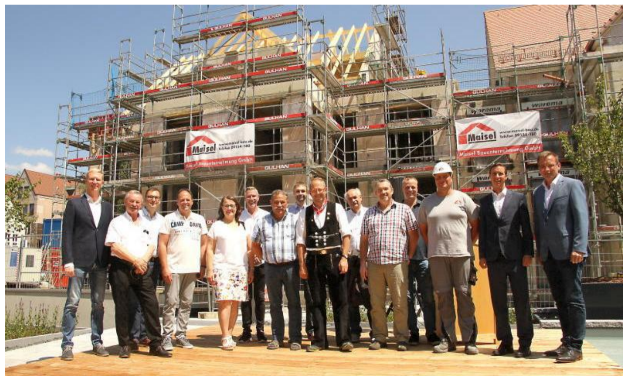
Herbert Kohl (M.), Jörg Maisel und Peter Uschalt (r.) feierten mit Handwerkern, Investoren, Anwohnern, Stadträten und Ehrengästen das Richtfest für den zweiten Bauabschnitt des Hersbrucker Altstadt-Carrés. Foto: J. Ruppert
