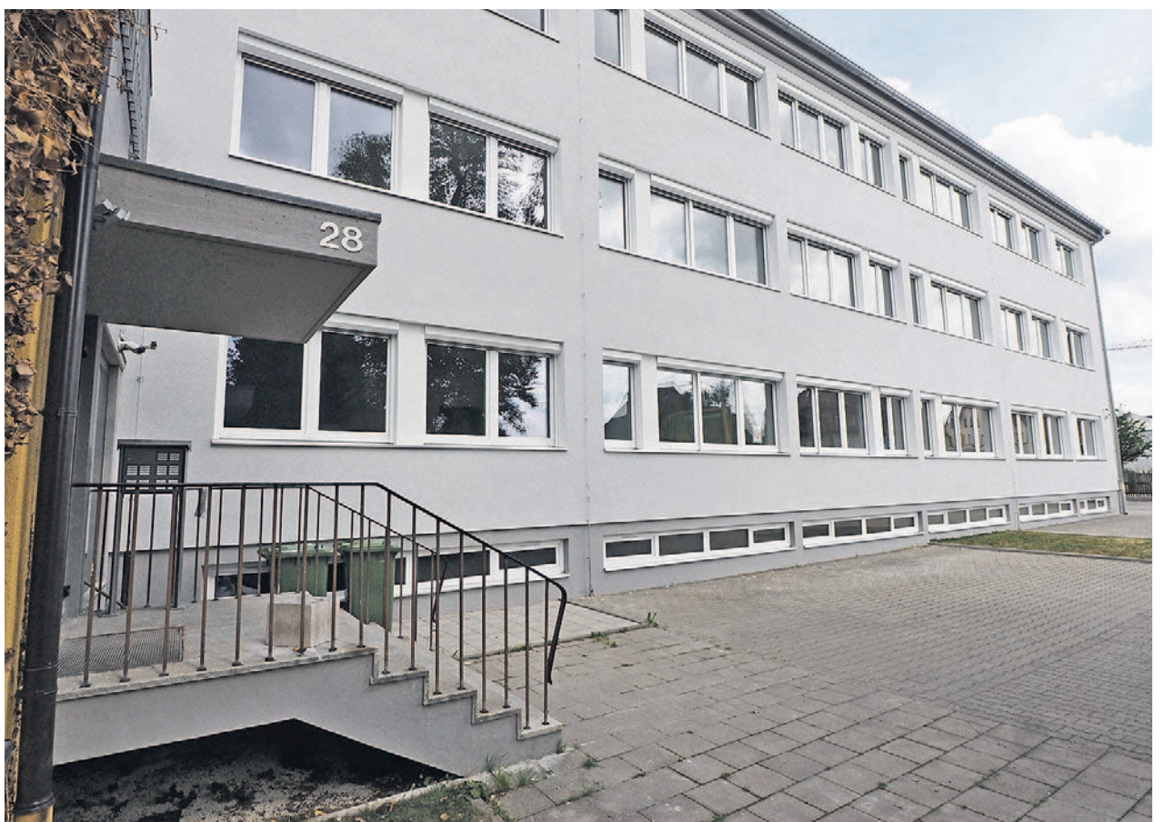
Soll Mitte bis Ende Juli bezugsfertig sein: Die neue Flüchtlingsunterkunft in der Nürnberger Straße, die die Regierung von Mittelfranken von dem Augsburger Investor Cengiz Yaver für zehn Jahre mieten wird. Derzeit müssen noch kleinere Restarbeiten erledigt werden, damit die Genehmigung erfolgen kann. Foto: Robert Renner
