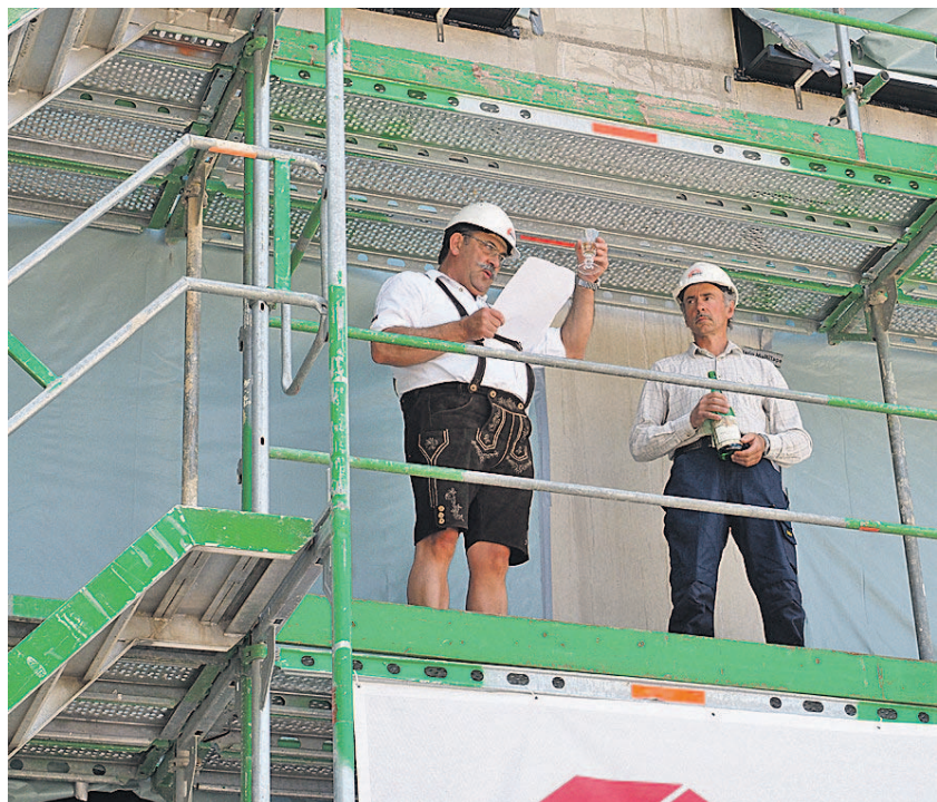
Es geht voran: Zwei Mitarbeiter der Firma Maisel-Bau, die bei der Feier kräftig gelobt wurde, hielten den Richtspruch für das Gesundheitszentrum auf dem früheren Bender-Areal an der Nürnberger Straße in Weissenburg. Dort entstehen derzeit drei Gebäude mit Gewerbeflächen und hochwertigen Wohnungen. Fotos: Robert Renner
