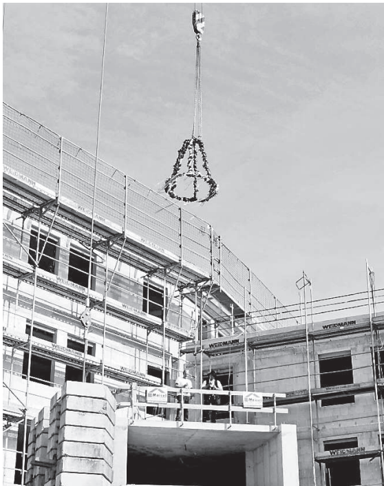
Die geladenen Gäste, darunter künftige Bewohner, genossen diesen Blick auf die Seniorenresidenz während des Richtfests.
