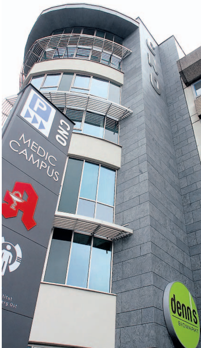
Der Campus Nürnberg Ost auf dem Ex-Dywidag-Areal setzt auf eine umweltfreundliche Klimatechnik. Foto: Eduard Weigert
