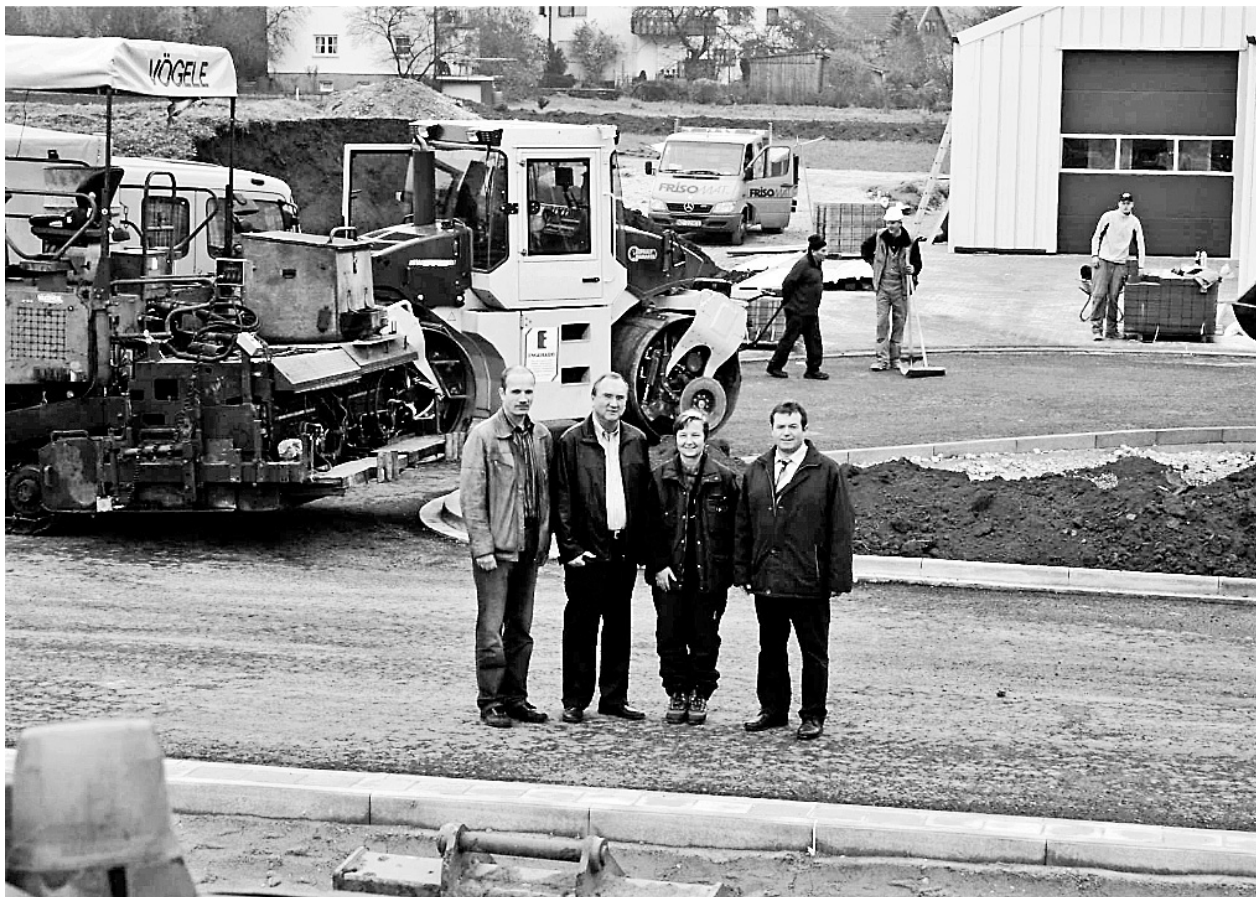
Bürgermeister Günther Rögner, Ursula Böhner, Walter Maisel und dessen Mitarbeiter Hans-Jürgen Balasus (von rechts) in der Endphase der Erschließungsarbeiten im Engelthaler Gewerbepark, rechts im Hintergrund die neue Lagerhalle von Ursula Böhner. Foto: D.Haas
